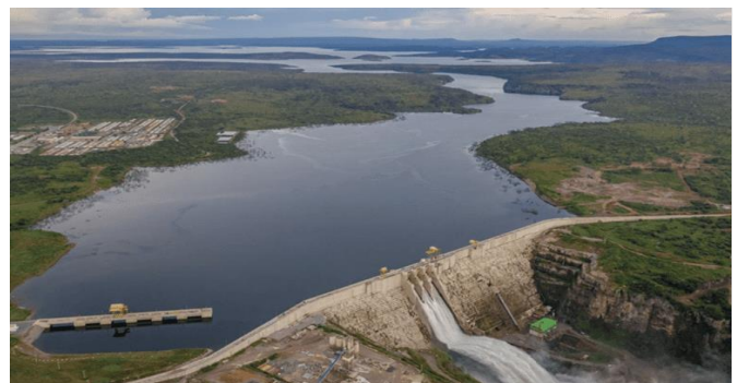
Wasserkraftanlage Laúca in Angola
