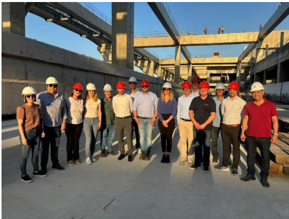
Abbildung 3: Auf der Monorail-Baustelle in Sao Paulo
