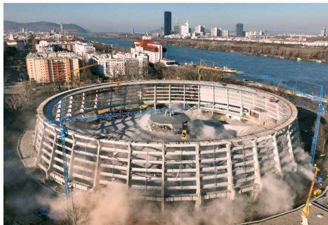
Rückbau Ferry-Dusika-Stadion in Wien 2022
